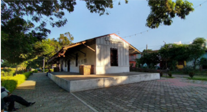
Evidencia de los trabajos de terracería efectuados en el Conjunto Ferroviario de Sitio del Niño, San Juan Opico, La Libertad. Fotografía tomada el 7 de marzo de 2017, Nancy Trujillo
