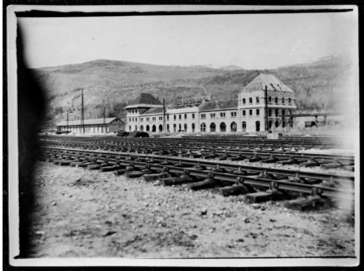
Obres de l'estació internacional de Latour de Carol-Enveitg, 1928-1929
