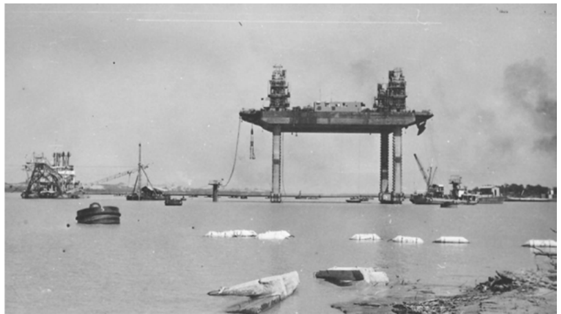
Figura 7. El pontón móvil o "isla flotante" en dos momentos, a la izquierda en navegación y a la derecha levantada sobre sus patas que se apoyan en el lecho del río, disposición para permitir ubicar el tubo debajo y posicionarlo en el lecho. Fuente: Ente Túnel Subfluvial.
