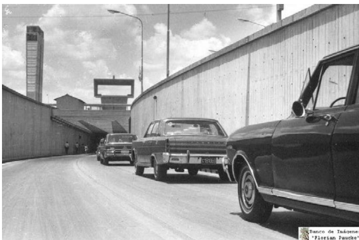
Figura 10. Primeros días de uso, aún con construcciones provisionales entre las torres de ventilación. Fuente: Banco de imágenes "Florian Paucke".
