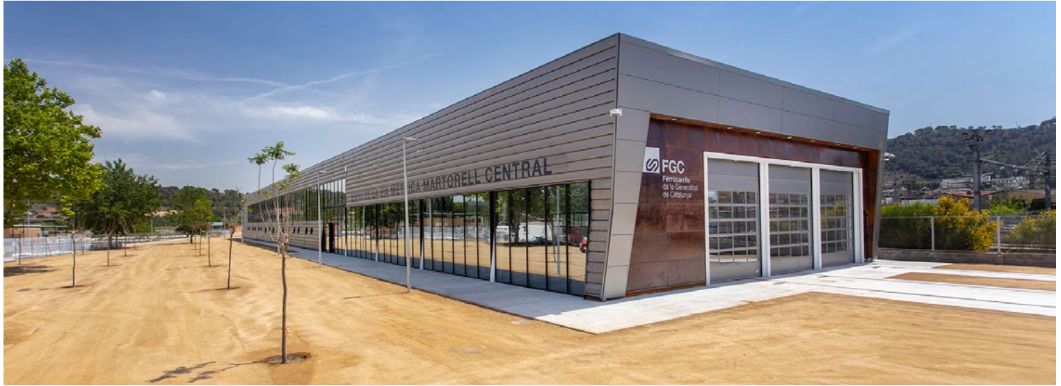
La nau "Espai de la Via Mètrica" que s'està condicionant com a espai de preservació i exposició a l'estació de Martorell Central. Foto Ramon Vilalta.
