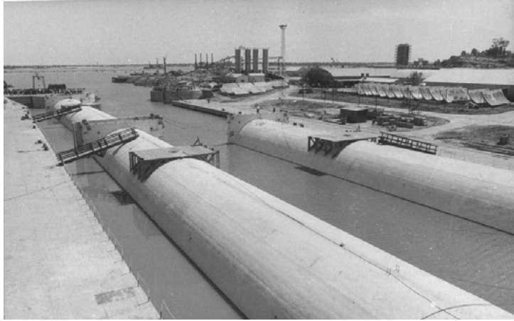
Figura 5. Dique inundado con compuertas abiertas para llevar los tubos al río. Fuente: Banco de imágenes "Florián Paucke".
