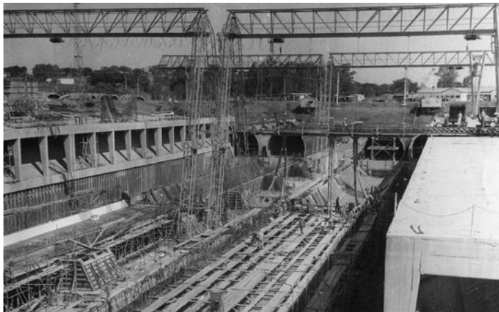
Figura 3. Dique seco en obras de construcción de "tubos".
