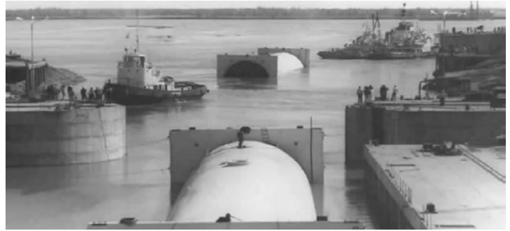
Figura 6. Los tubos remolcados, saliendo del dique hacia el río. Fuente: Ente Túnel Subfluvial.
