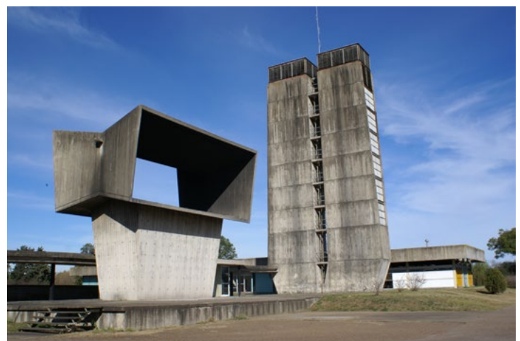
Figura 11. Torres de ventilación. Fuente: fotografía del autor.
