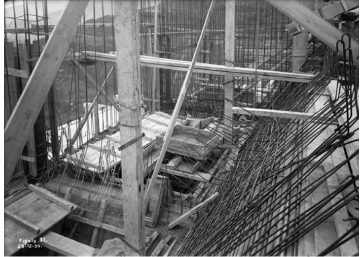
Preparació del forjat de les tremujes
