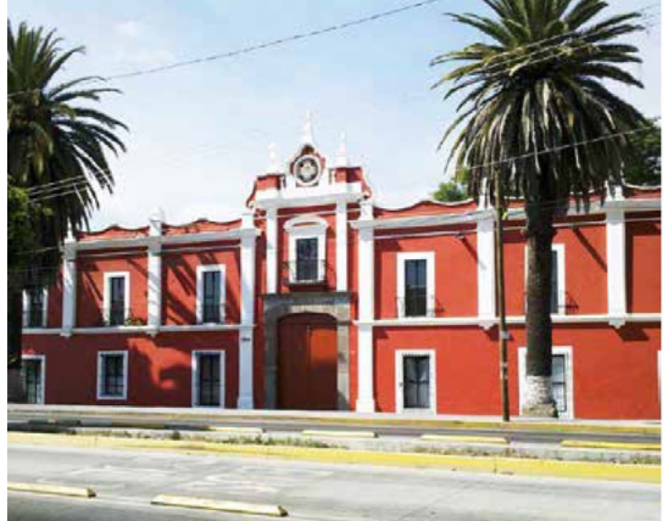
Fachada actual de la ex fábrica textil Molino de En medio. (Colección CMCPI AC)
