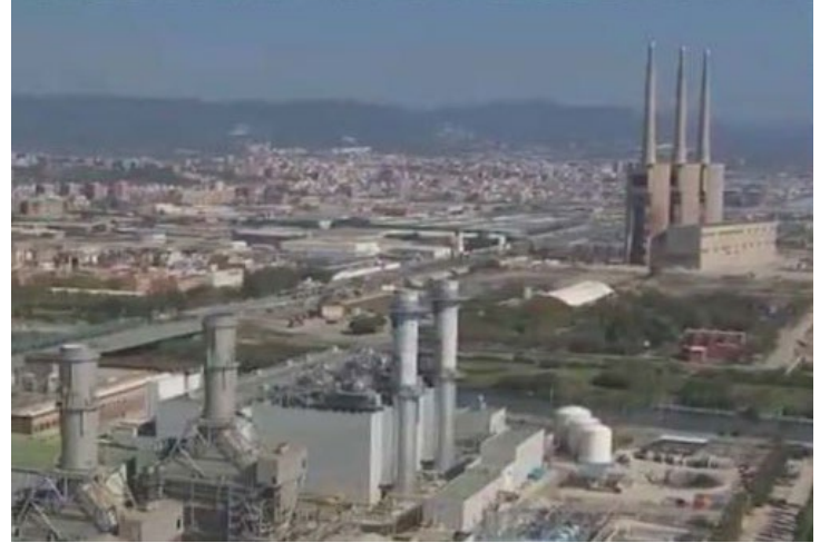
Visió de conjunt de les centrals modernes del Besòs
