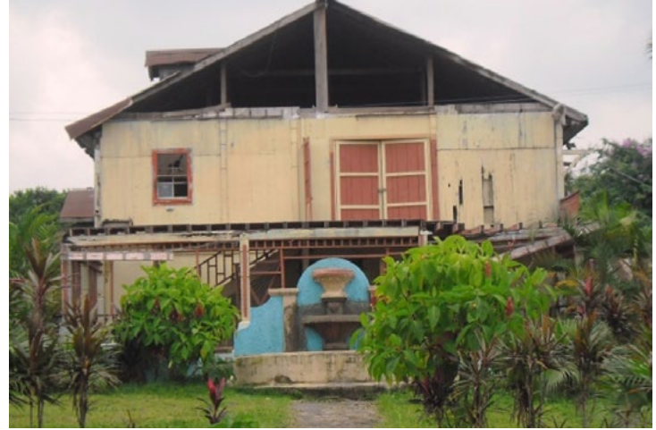
El mismo edificio en el año 2013. (Foto: Rubén Larios)
