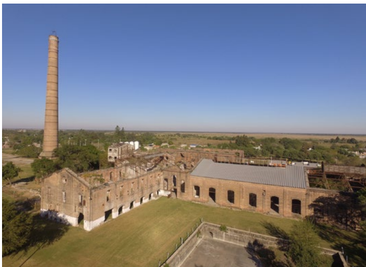
Estado actual del edificio de la fábrica de Villa Ana Foto: Luis Müller
