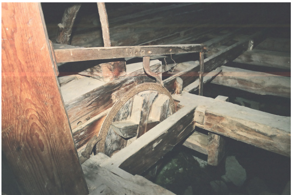
Mecanisme d'avançada. Serradora de Baiasca (1987)
