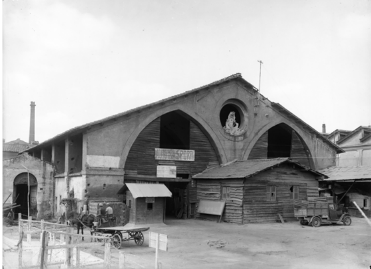
El Arsenal Pontificio utilizado como almacén para los coches de transporte, 1929. (ICCD, Gabinete Nacional de Fotografía)
